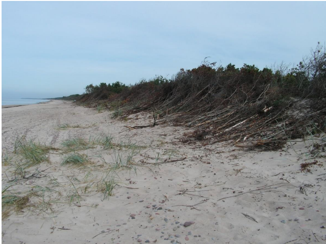
6.2. pav. Šiauriau terminalo trasos kopagūbrio šlaitas sutvirtintas šakų klojiniais.
