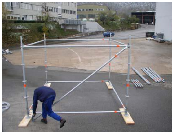
Rys. 4. Montaż pierwszej ramy poziomej rusztowania
