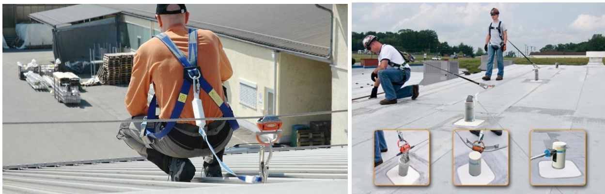
Rys. 2. Przykłady poziomych systemów asekuracyjnych
