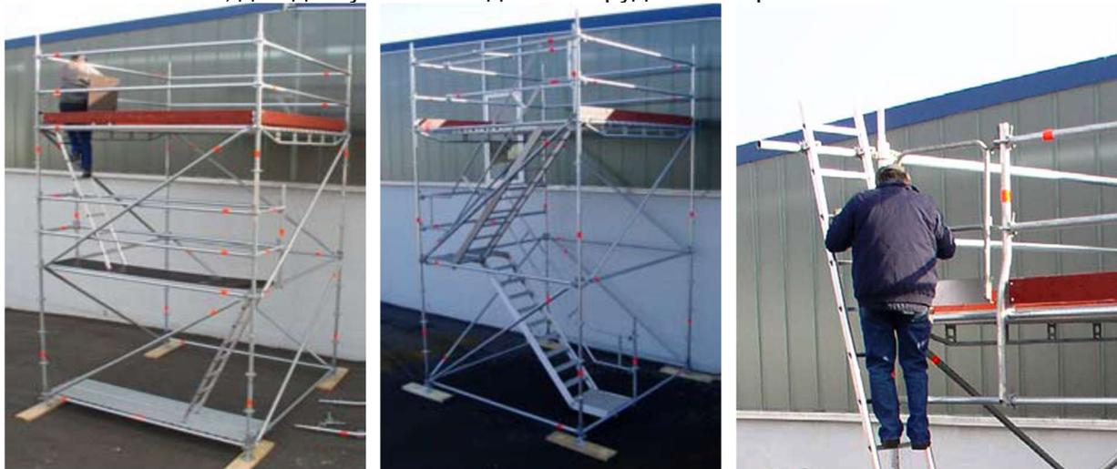
рис. 5. Образцы оборудования средств подъема на ярусы строительных лесов
