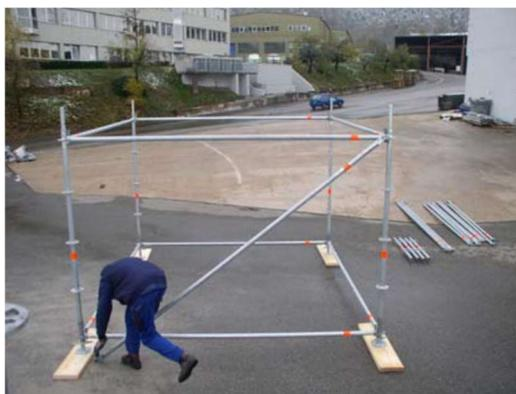
рис. 4. Монтаж первой горизонтальной рамы строительных лесов
