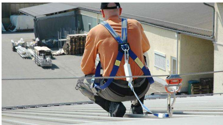
2 rys. Przykłady poziomych systemów bezpieczeństwa
