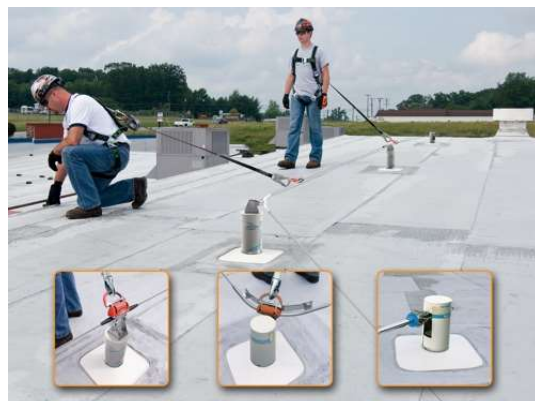
2 rys. Przykłady poziomych systemów bezpieczeństwa
