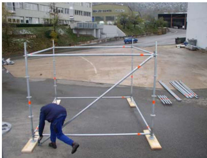
4 rys. Montaż pierwszej ramy poziomej rusztowania
