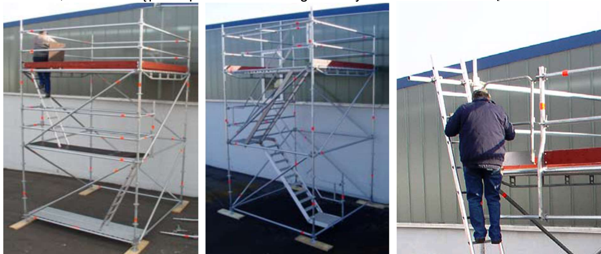
5 rys. Przykłady montażu środków dostępu na piętra
