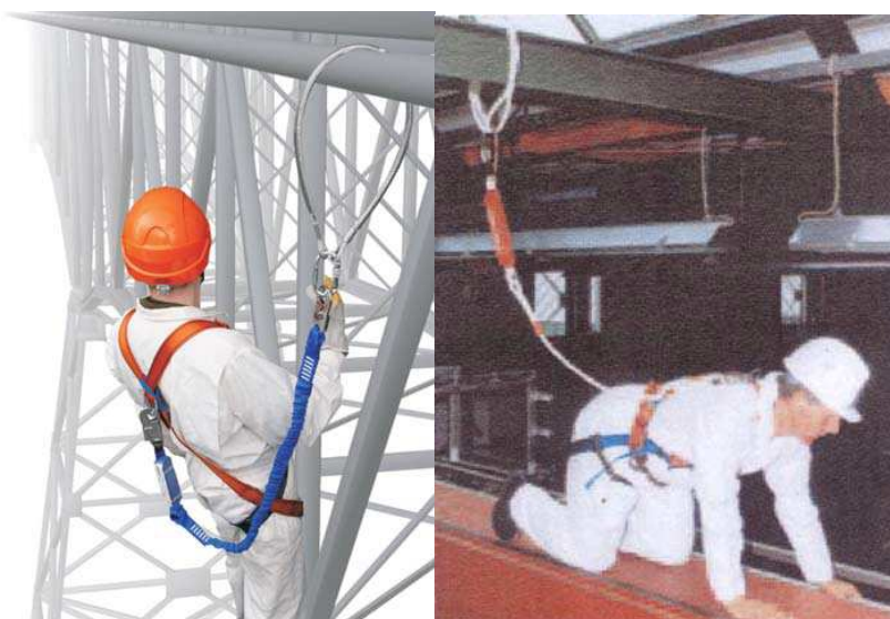
Рис. 4. Примеры крепления карабина страховочного ремня
