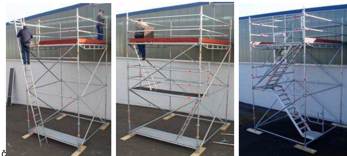
Рис. 2. Образцы оборудования средств подъема/спуска на/с лесов
