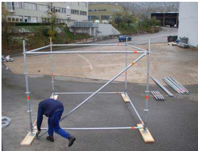
Рис. 1. Монтаж первой горизонтальной рамы лесов
