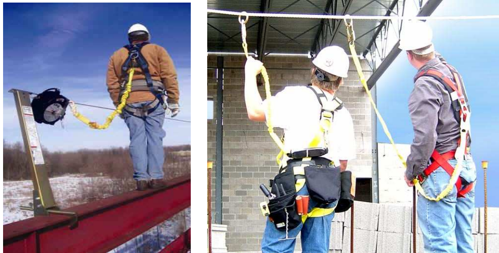
Рис. 7. Примеры использования систем горизонтальной страховки
